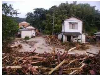
愛媛県新居浜市郷地区(楠崎川) 死者1名、全壊8戸、半壊3戸
