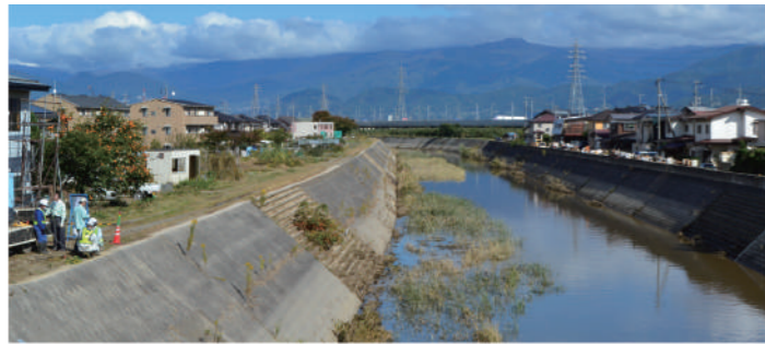
1【浅川】左岸（写真左）へ越流
