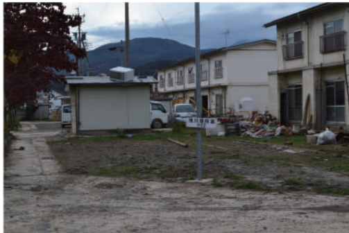
2【市宮沖団地】街灯柱に浅川堤防高の表示
