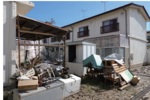
3【市宮沖団地】多くの棟で1階天井まで浸水
