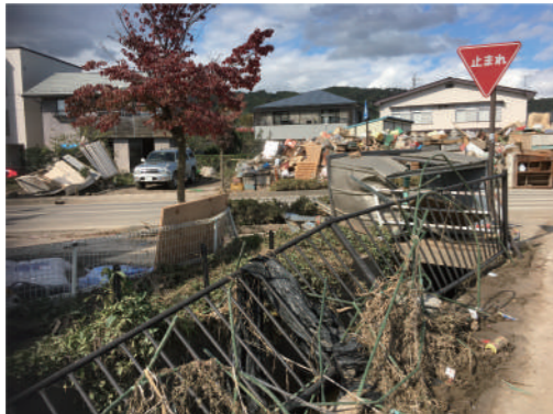
6【本町五組】水圧により倒された柵
