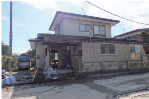
4【本町五組】裏手が浅川。1階天井まで浸水。
