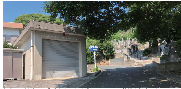
伊方町三崎地区・農道を含めた避難ネットワーク整備を提案した
