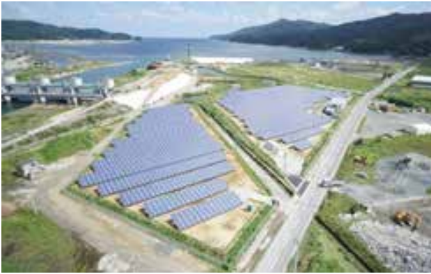
赤前地区 (1.6Mwh)
