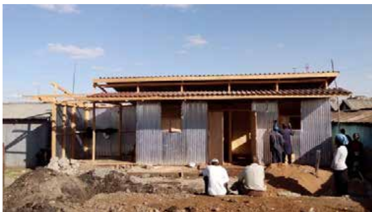
建設時の様子。写真中：若者たちが床仕上げを行っている。写真右：ハイサイドライトを採用し、自然光のみで十分な採光が得られるよう工夫した。
