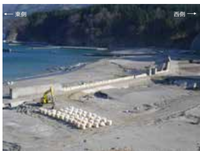
写真-1 破壊された綾里湾白浜海岸の海岸堤防 (2011年4月撮影)
