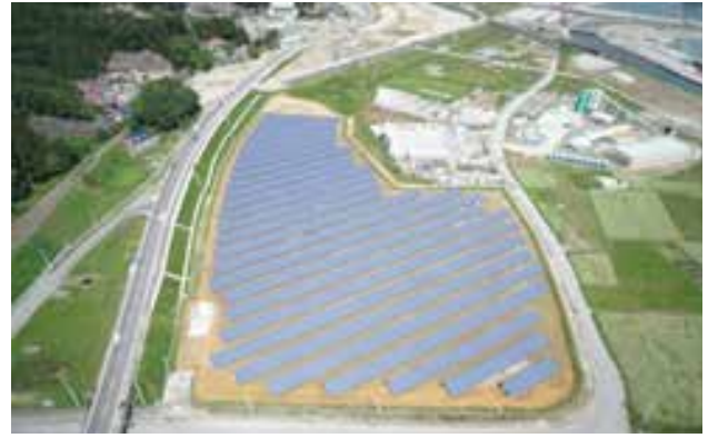
田老地区 (2.4Mwh)
