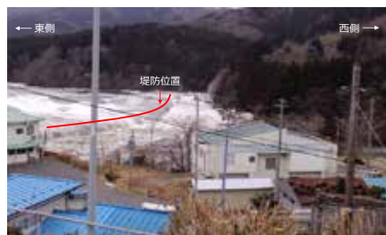
写真-2 津波が堤防を越流する様子 (2011年3月11日15時19分ごろ)
