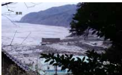
写真-3 漁港が破壊された様子 (2011年3月11日15時40分ごろ)
