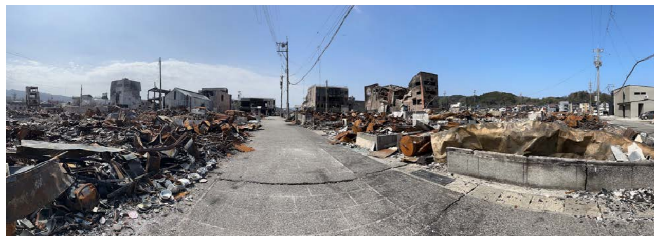
①輪島朝市付近 火災によってほとんどの建物が瓦礫となっている
