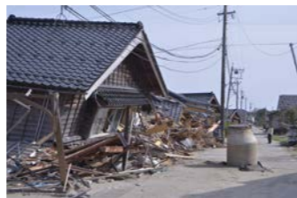
③液状化 複数のマンホールが1m50cm程度浮き上がる
