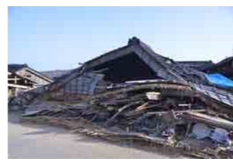
若宮八幡神社付近に位置する旧角海家住宅(重要文化財)は、2007年の地震で全壊した後に復元されたが、再び全壊となった。
