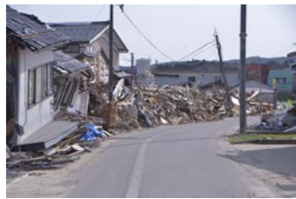
⑦道路状況 道路は啓開されているが片付け作業は進んでおらず街中の住民の姿も輪島と比較してかなり少ない
