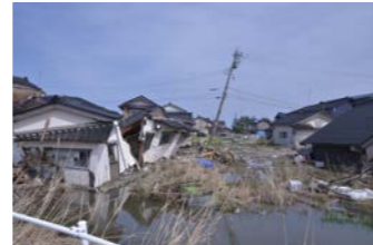
①鵜飼川右岸側の倒壊被害 津波による家屋流出は確認されず、揺れによる倒壊が顕著
