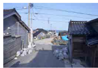
輪島市門前町黒島地区の若宮八幡神社では鳥居が崩壊。
