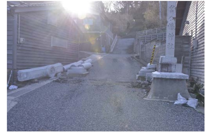
②若宮八幡神社の鳥居 鳥居が壊れている様子が確認される。
