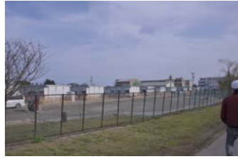
⑩仮設住宅 宝立小学校(避難所)の校庭に仮設住宅が建設。まもなく入居開始
