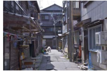
②海士町での被害状況
