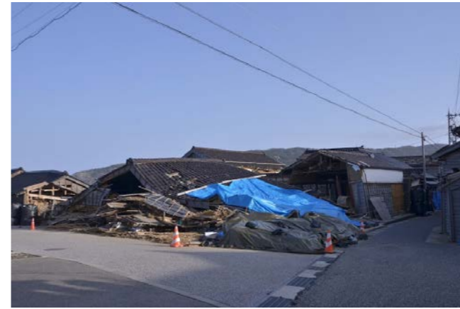
①旧角海家住宅 2007年の能登半島地震で被災後、耐震性能を確保して復元したが、倒壊している。
