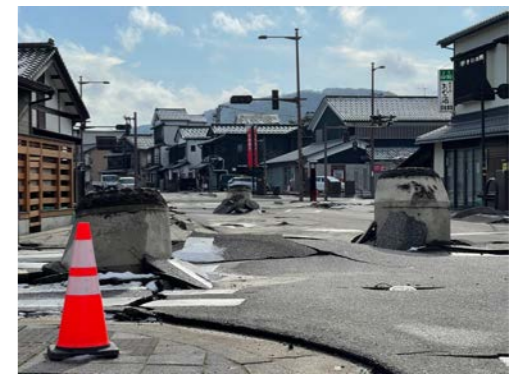
写真:4m隆起した黒島港内では水が完全に干上がっている
