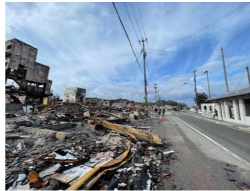
写真:輪島市朝市地区の火災跡、焼失範囲は約50,800m 2 に及ぶ
