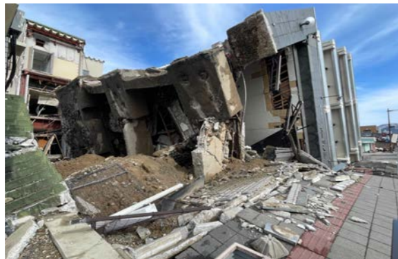
写真:隆起した土地と転倒したビル(輪島市)
