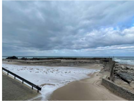
写真：液状化により隆起したマンホール群はライフラインだけでなく避難・救援交通を寸断した（輪島市）
